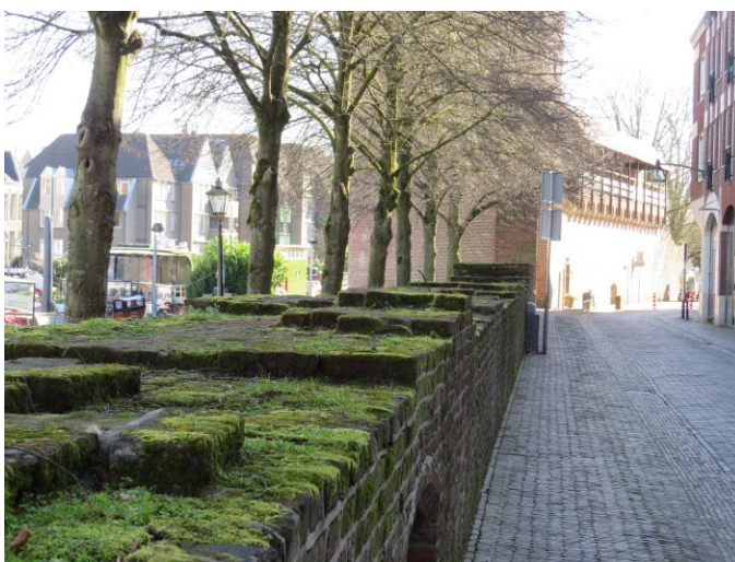
Figuur 2. Bovenzijde stadsmuur
